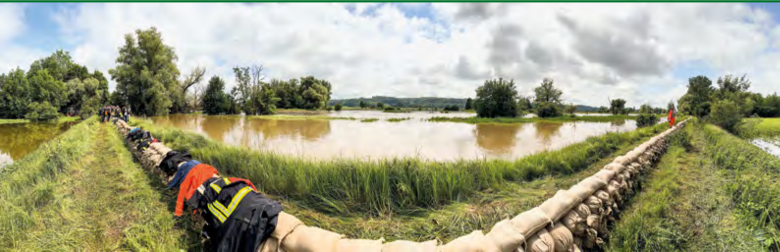
Rund 2000 Sandsäcke stützten den Amperdam bei Palzing.
