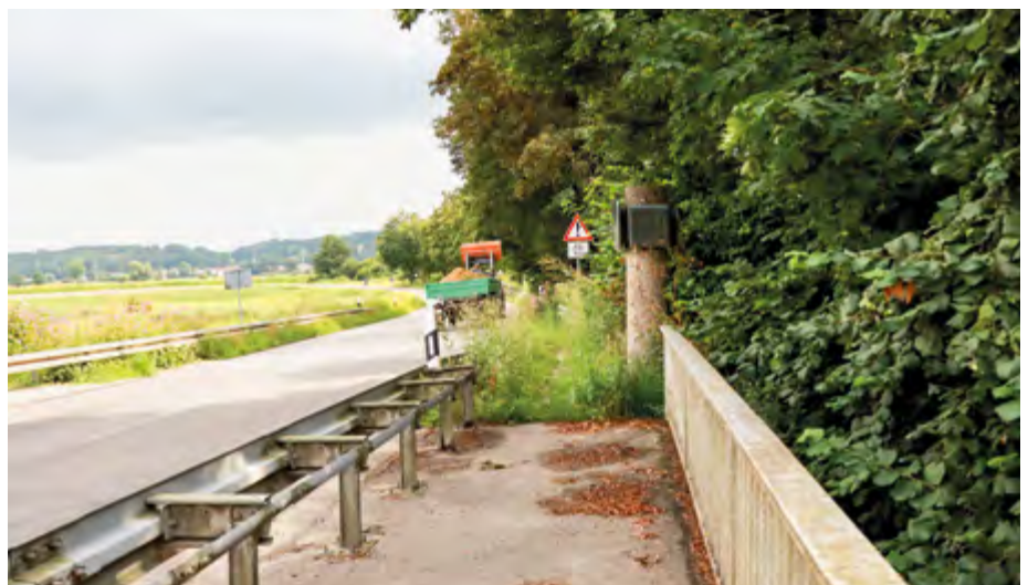
Die Amperbrücke wird verbreitert für einen Fuß- und Radweg als Verbindung von Palzing und Haindlfing.
